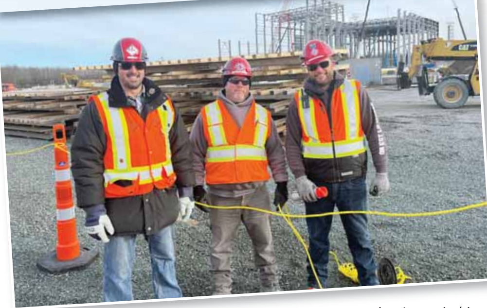
Benoît Lapierre, à gauche, RSS au chantier Nemaska Lithium en Mauricie.
