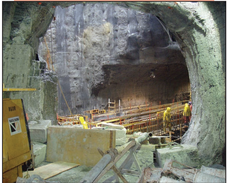
Des centaines de charpentiers-menuisiers du Local 9 ont travaillé sur le chantier du métro de Laval.
