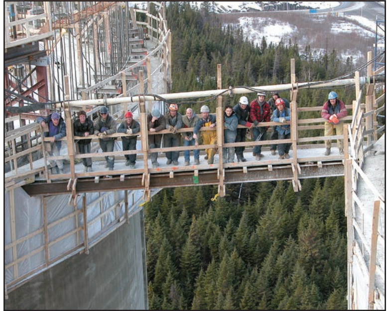
Photo prise au silo 3 du chantier Alouette à Pointe-Noire, près de Sept-Îles.
